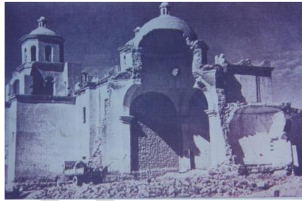
Fotografía 2. Templo histórico afectado por las lluvias de 1955.
